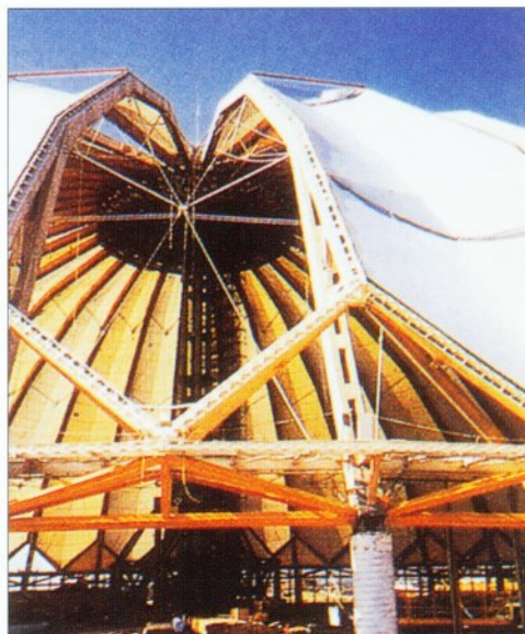
出雲ドーム内の機器やネットを昇降する FE
